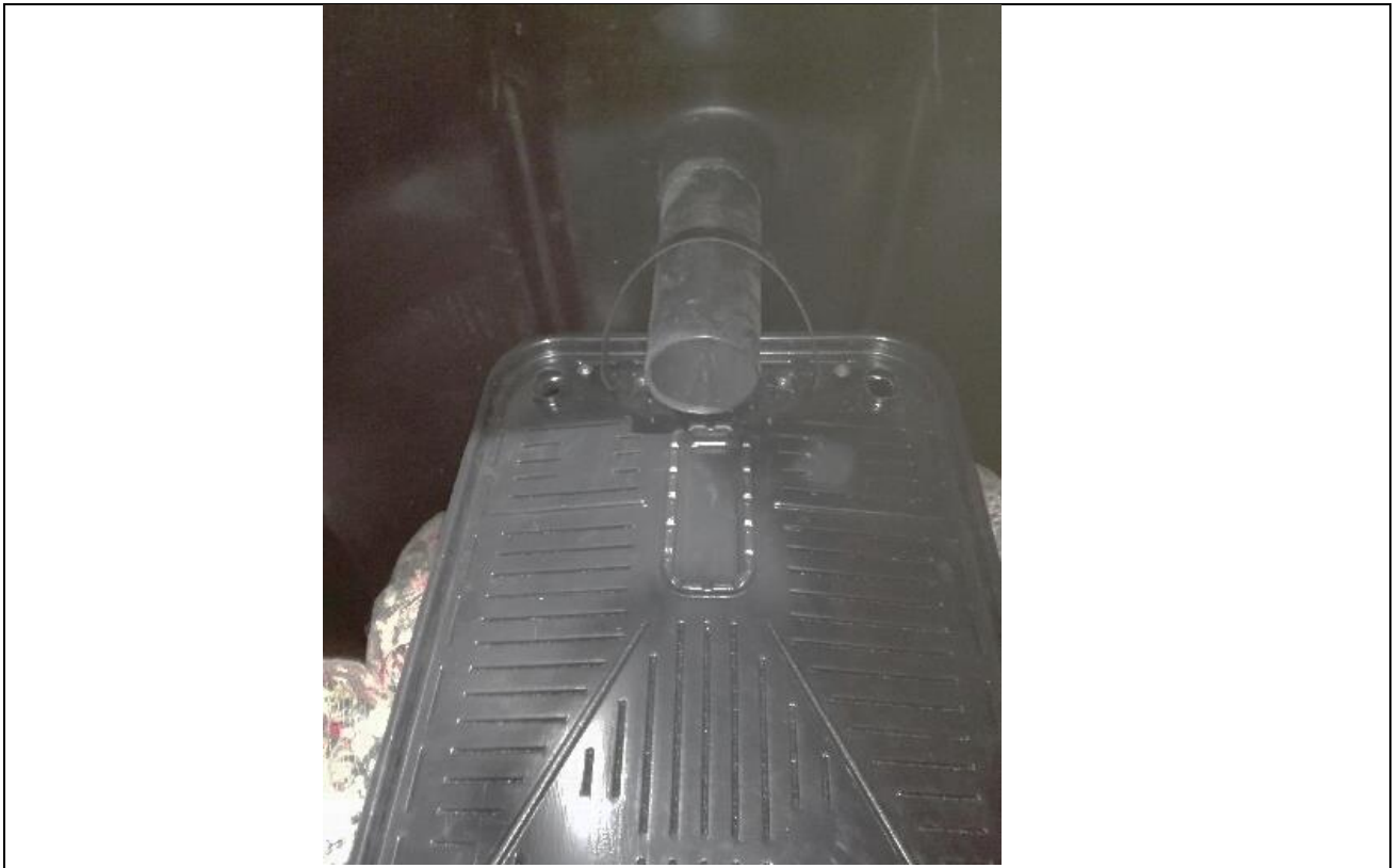
Kuva 9. Jakoaltaan asennus BioRami -puhdistamon sisälle
