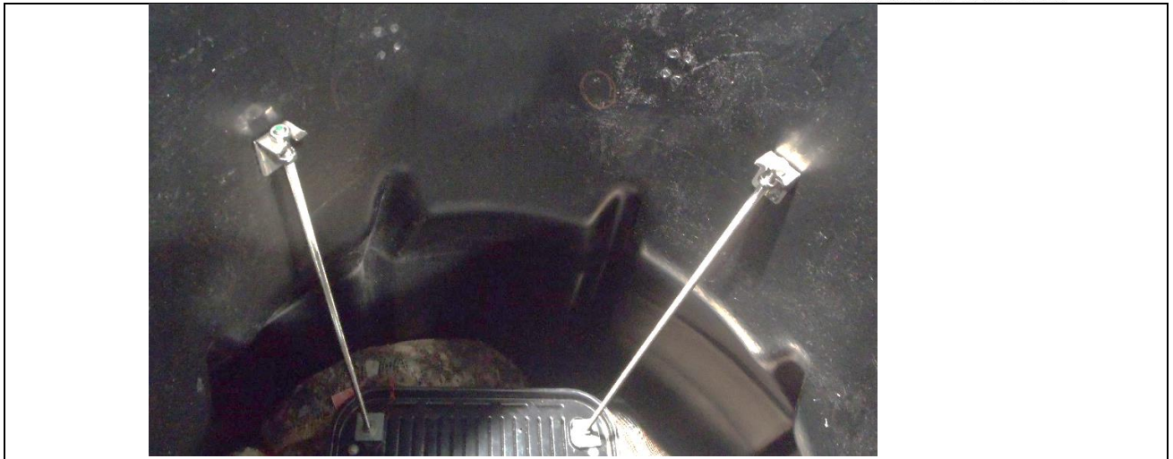
Kuva 10. Jakoaltaan kierretankojen kiinnitys huoltokaivoon.
